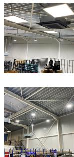
**Technische Daten Noxion LED Highbay Concord V4.0 Wählbare Wattzahl 100-120-150-200W 34000lm 90D - 840/852/865 CCT | IP65 - 0-10V Dimmbar - Ersatz Für 520W**
