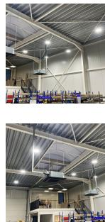
Technische Daten Noxion LED Highbay Concord V4.0 Wählbare Wattzahl 100-120-150-200W 34000lm 120D - 840/852/865 CCT | IP65 - 0-10V Dimmbar - Ersatz Für 520W
